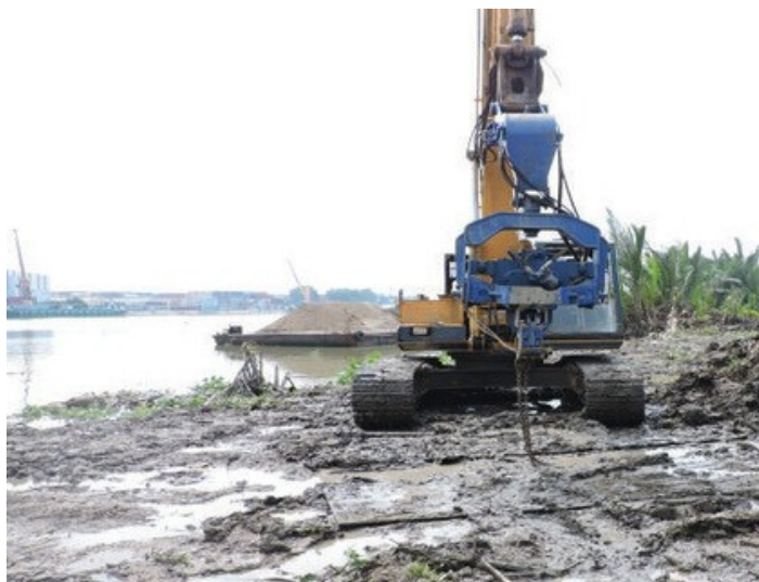
Bờ bao chống ngập bằng cừ bản nhựa uPVC Z80. Địa điểm: Rạch Cống Đôi, P.28, quận Bình Thạnh, Tp.HCM
