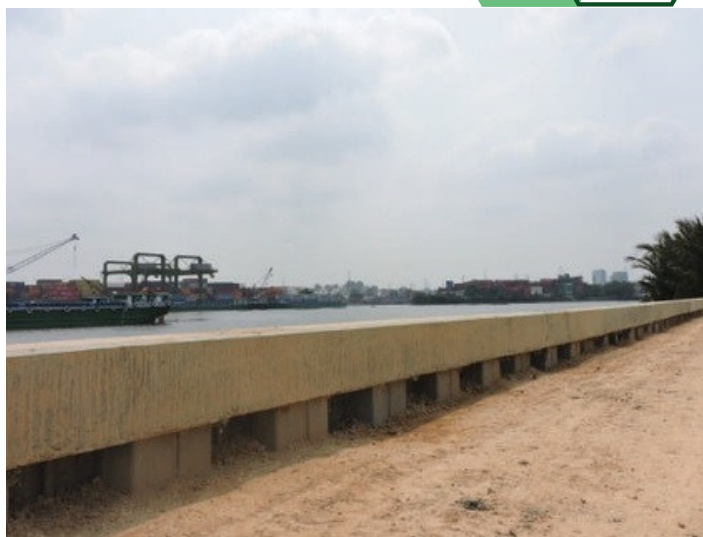
Bờ bao chống ngập bằng cừ bản nhựa uPVC Z80. Địa điểm: Rạch Cống Đôi, P.28, quận Bình Thạnh, Tp.HCM
